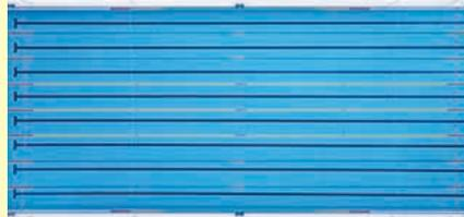
国際大会を行う50mプールは、公認規則では50mちょうどではなく、50m2cmとなっている。プールの両端に厚さ1cmの計測用のタッチ版を設置するため、このタッチ版を込みで50mとなるように設計されている。
